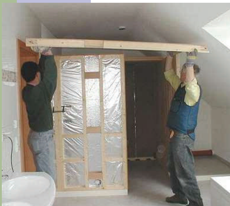
Der Einbau einer Sauna in der Dachschräge
